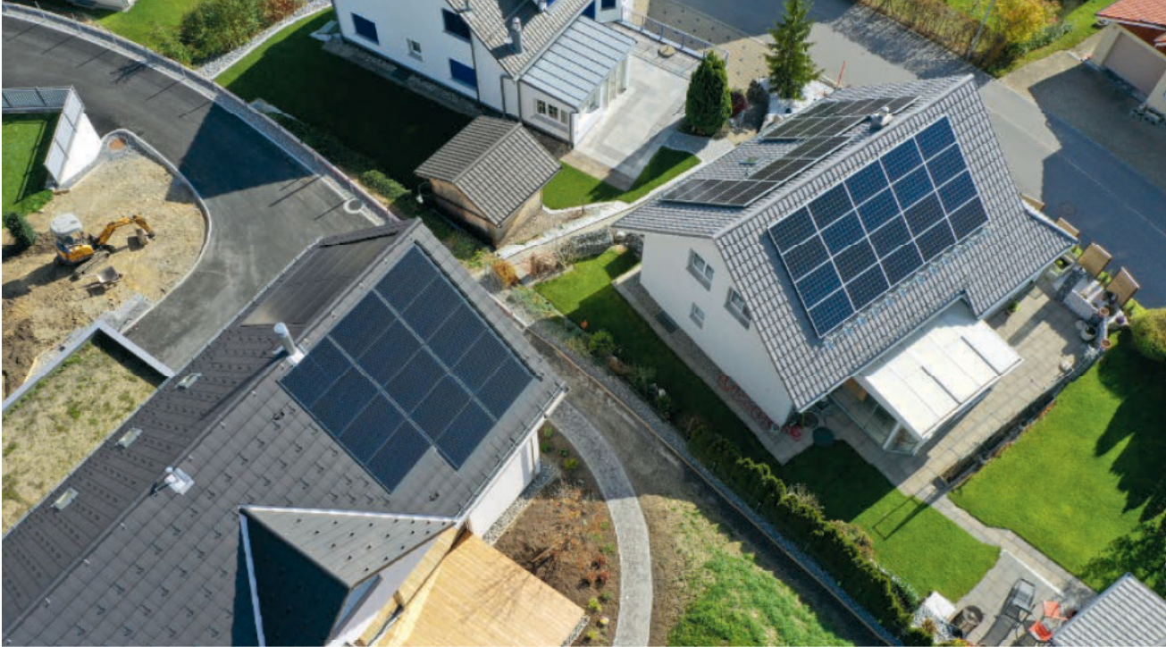
Ein Beispiel für eine Indach- (links) und eine Aufdach-Anlage (rechts).
